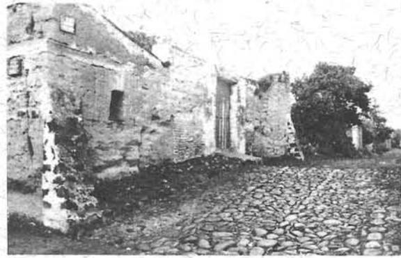
EL EMPEDRADO EN LOS PUNTOS DE CAMBIO DE PENDIENTE ACTUA COMO CONTENCIÓN DEL APISONADO DE TIERRA EVITANDO LOS ESCURRIMIENTOS POR AGUAS LLUVIA
