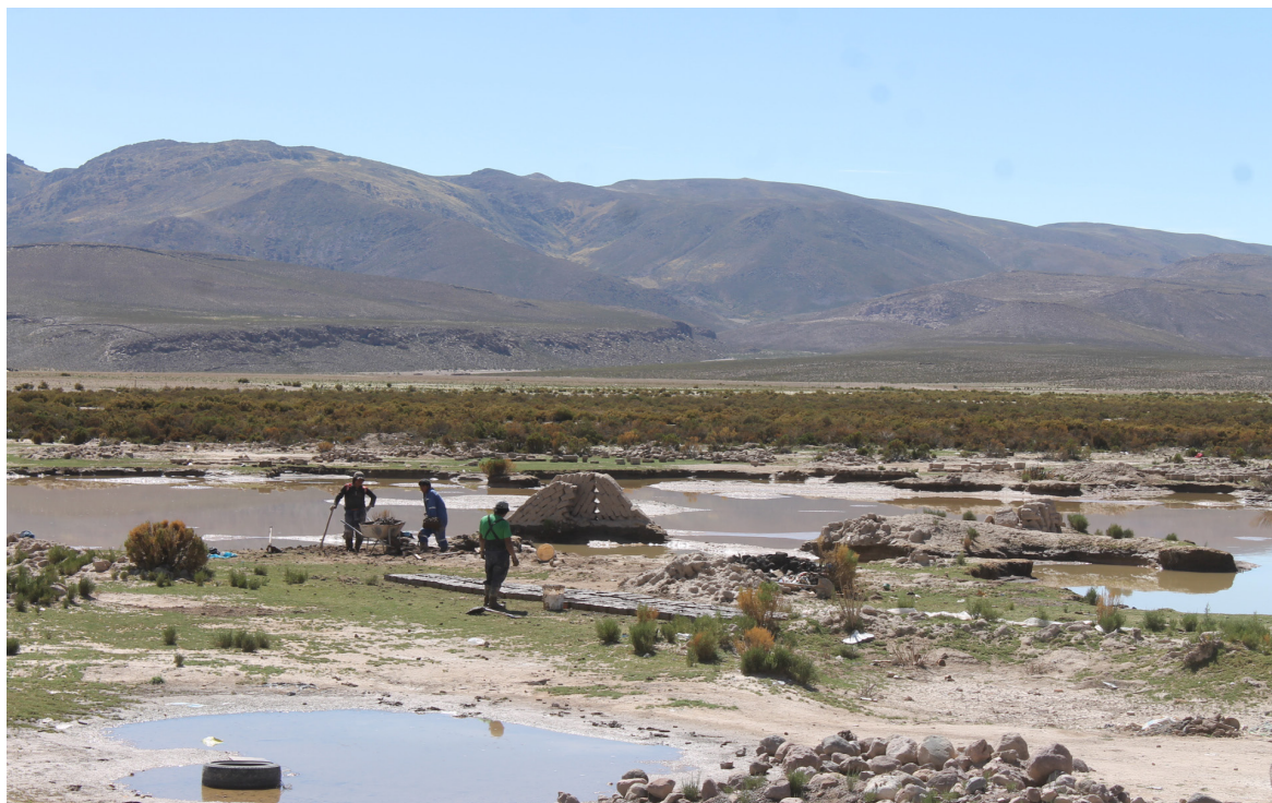
Figura 3. Cariquima 2013. Bolivianos trabajando en la confección de ladrillos de barro, principal insumo para la actual construcción de viviendas en estas localidades de frontera (Fotografía A. Garcés 2013).
