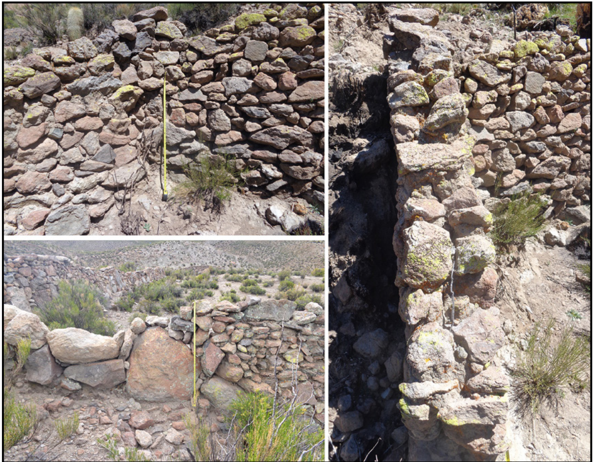
Figura 7. Vista frontal de un muro construido con la técnica o modo 1, escala 1 m (arriba); combinación de la técnica 1 con la 3 en el picardo del canchón CPH16, escala 1 m (abajo); detalle en el que se observan las dos hileras de roca que lo componen (derecha).
