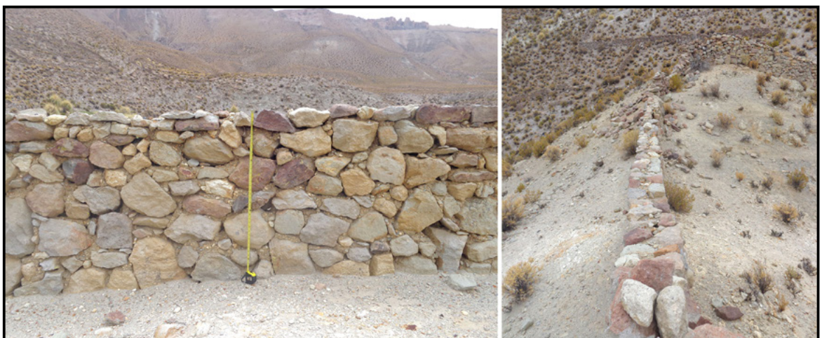
Figura 8. Vista frontal de un muro construido con la técnica o modo 1, escala 1 m (izquierda); detalle en el que se observan las dos líneas de roca que lo componen (derecha).
