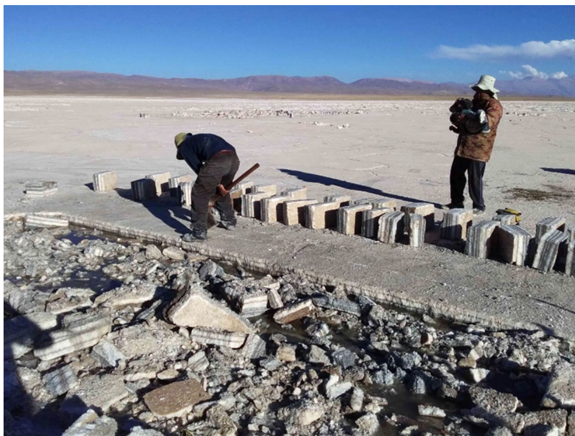
Figura 6. Marcando el banco para hacer la trenchada .
